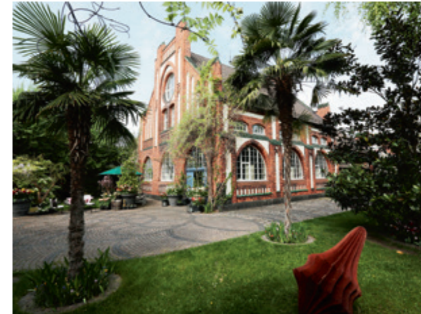
Altes Pumpwerk Neckarau, Mannheim
