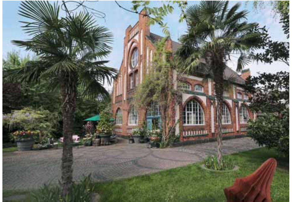
Altes Pumpwerk, Neckarau, Mannheim
